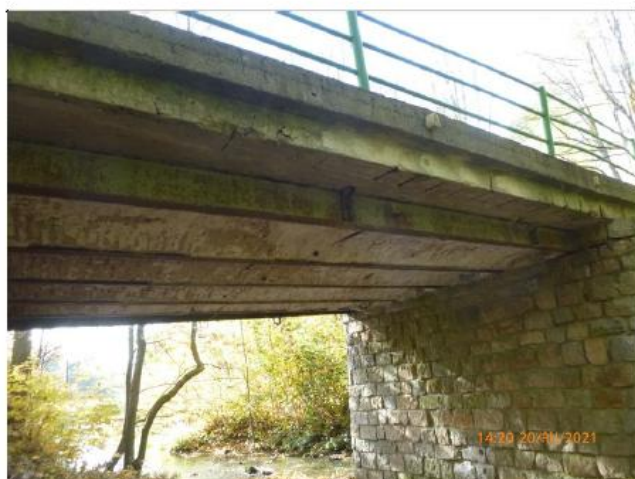
Konzola v 1. poli vpravo má místy odkryté třmínky.
