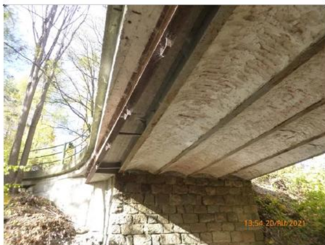
Konzola v 1. poli vpravo má místy odkryté třmínky.
